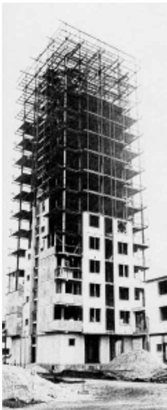
L'opération de La Muette en construction
