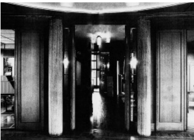
Séjour, les poteaux sont en béton brut.
