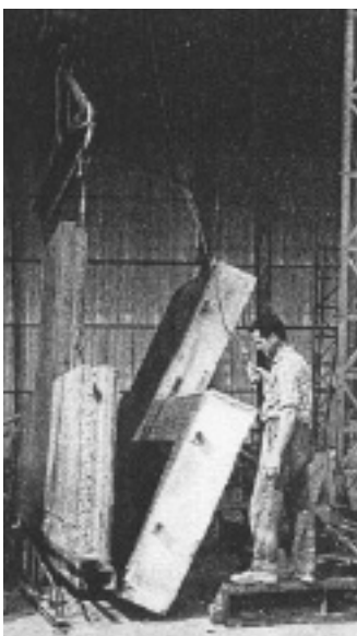
Démoulage d'une allège
