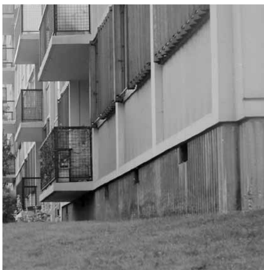
>>> À droite de l'image on aperçoit le détail des poteaux d'angle en creux.
