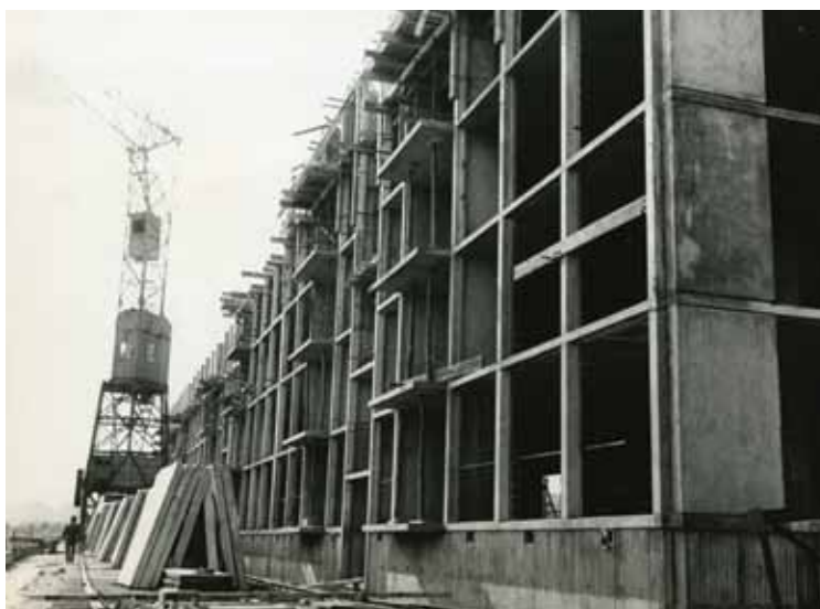
>>> Les façades ont conservé leur grande régularité, visible dans cette vue du chantier en cours.
