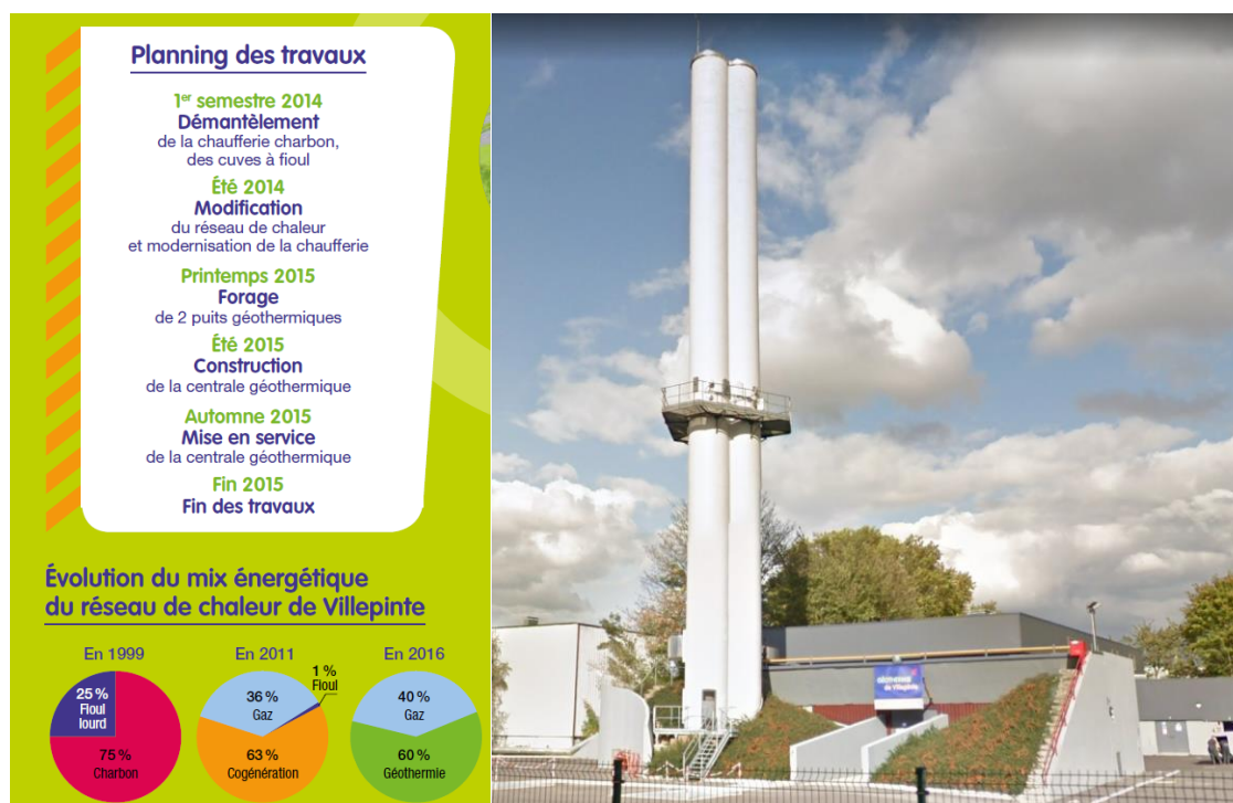
Figure 106 – Centrale géothermique de Villepinte ayant permis le démantèlement d'une chaufferie charbon
