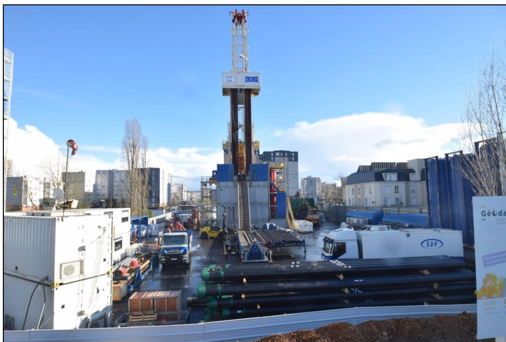
Figure 102 – Photo d'un site de forage (Dammarie-les-Lys, 2017)
