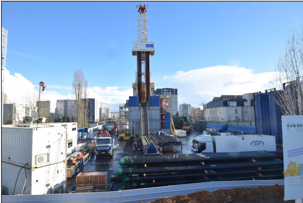
Figure 22 – Photo d'un site de forage (Dammarie-les-Lys, 2017)
